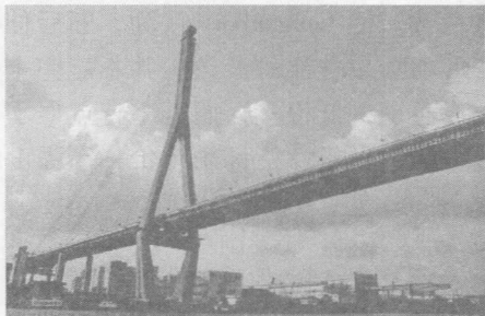
图 1-20 上海南浦大桥
