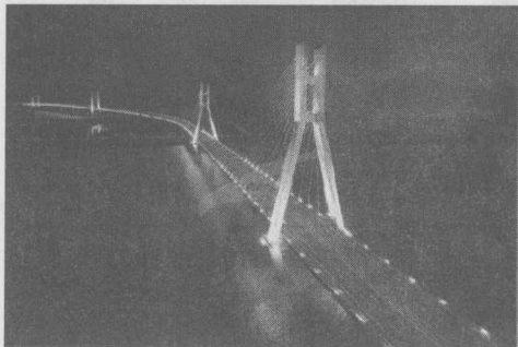
图 1 江苏润扬长江大桥
