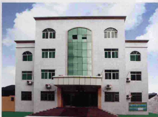
龙岗村委新大楼
