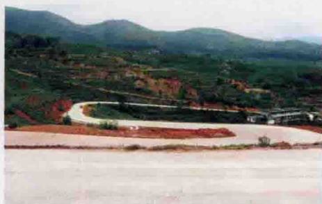
外出侨贤乡贤热心桑梓铺筑的硬底化公路
