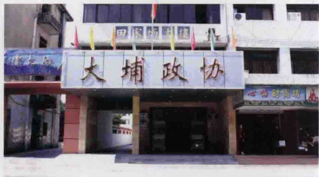
修葺一新的大埔县政协综合大楼
