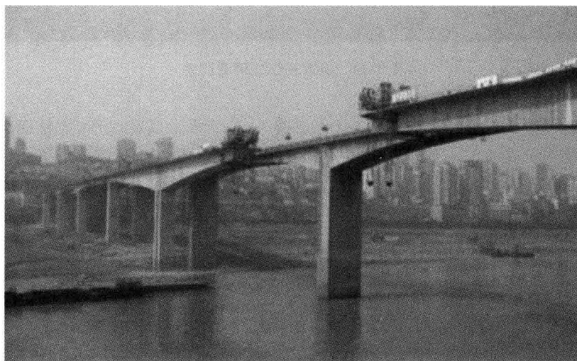
图 1-12 重庆石板坡长江大桥复线桥
