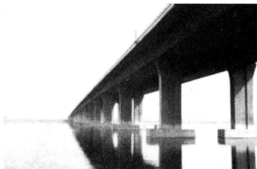
图 1-7 洛阳黄河公路大桥
