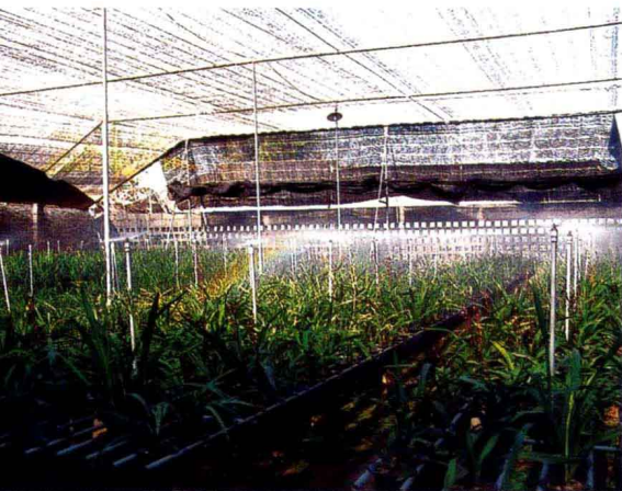
装置喷雾设施
