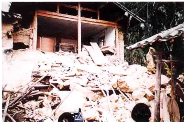
▲ 2001年10月27日，永胜县境内发生里氏6.0级地震，造成了人员伤亡、牲畜死亡、房屋倒塌和生命线工程严重受损，直接经济损失54599万元。（丽江行署 供）
