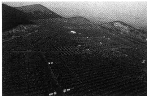
图 0-11 20MW 光伏电站
