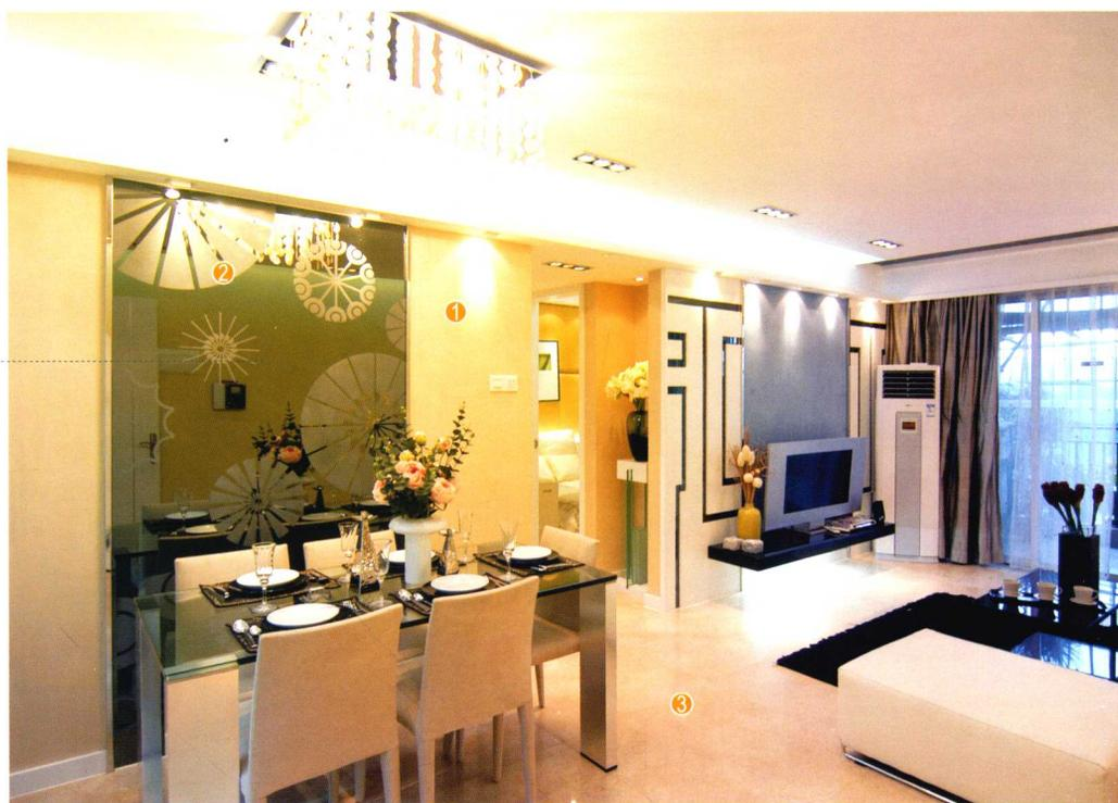
餐厅背景墙面用水泥砂浆找平，镜子基层用木工板打底，剩余墙面满刮三遍腻子，用砂纸打磨光滑，刷底漆、有色面漆，安装踢脚线。用托压固定的方式将灰镜固定在底板上。
