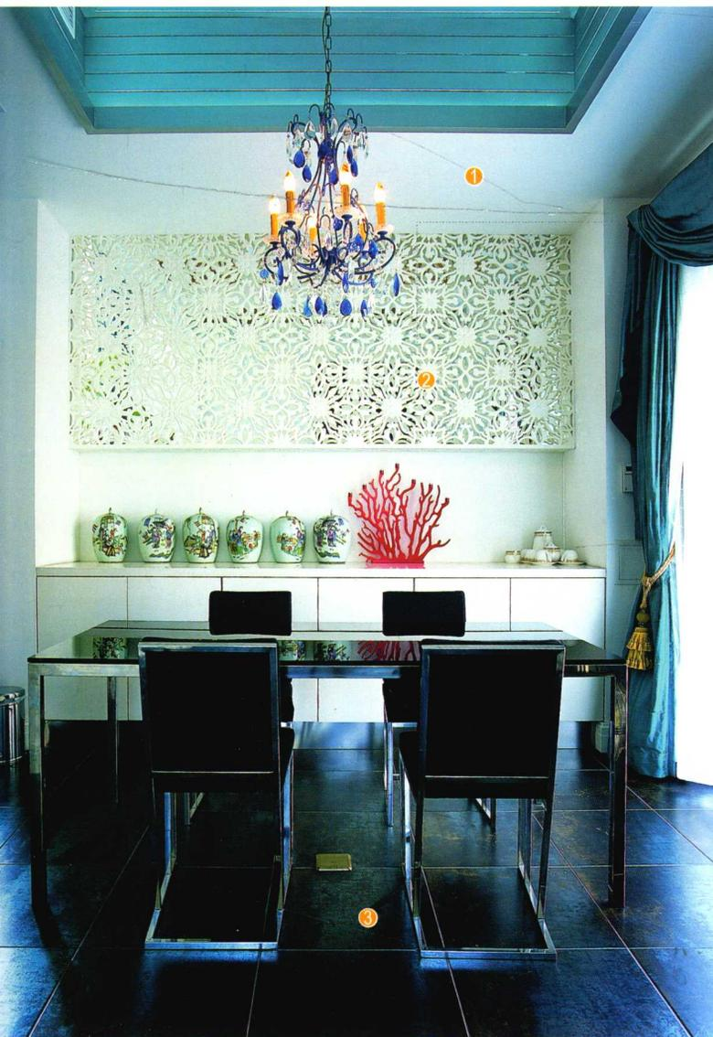
餐厅背景墙面用水泥砂浆找平，用木工板做出储物矮柜，贴装饰面板后刷油漆。剩余墙面满刮三遍腻子，用砂纸打磨光滑，刷底漆、面漆。用螺钉固定成品通花板。
