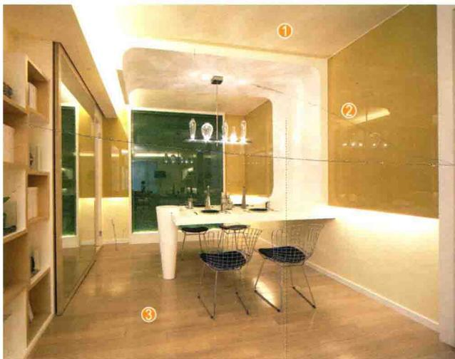
用木工板及硅酸钙板做出餐厅背景墙面上的弧形造型及灯槽结构，部分墙面满刮三遍腻子，用砂纸打磨光滑，刷底漆、面漆。最后固定亚克力板及踢脚线。
