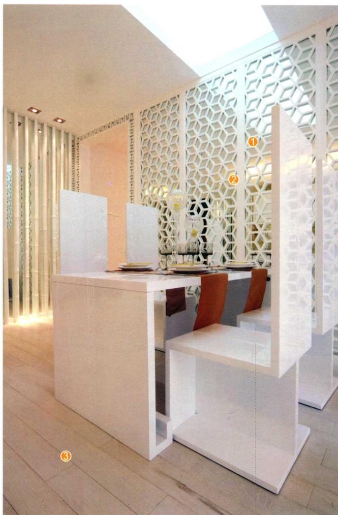
餐厅背景墙面用水泥砂浆找平，整个墙面用木工板打底，以粘贴固定的方式将银镜固定在底板上，用密封胶密封，最后将订制的通花板固定在银镜上。
