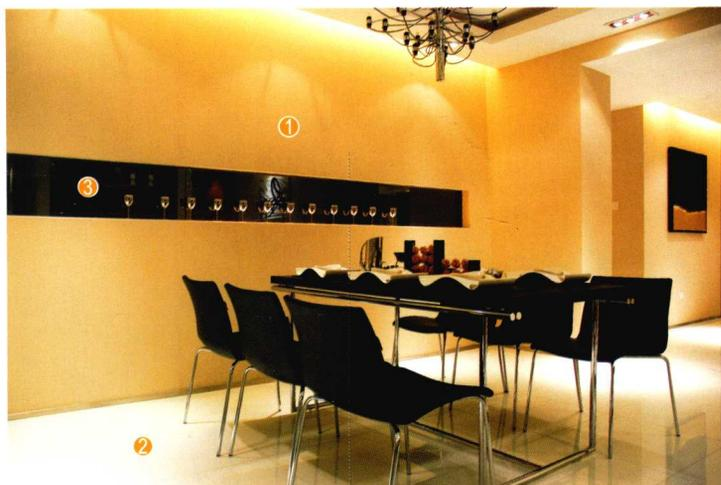
餐厅背景墙用水泥砂浆找平，黑镜基层用木工板打底，剩余墙面满刮三遍腻子，用砂纸打磨光滑，刷一层基膜，贴壁纸。用玻璃胶将黑镜固定在底板上，最后安装踢脚线。
