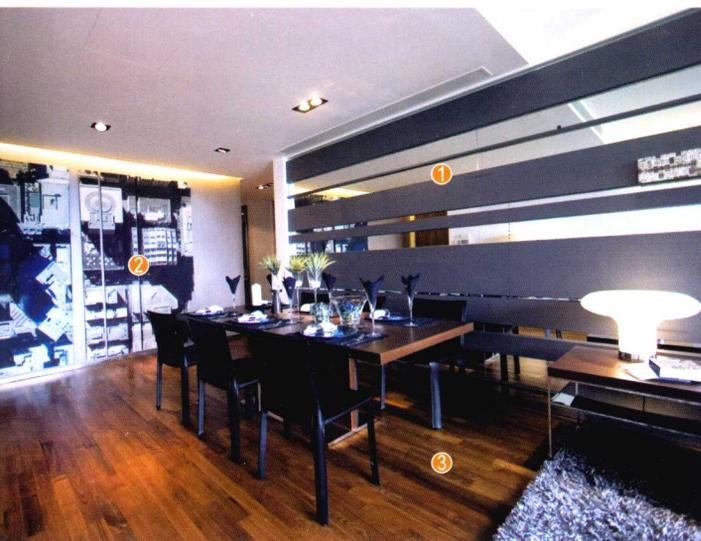
餐厅背景墙面用水泥砂浆找平，整个墙面做防潮处理后用木工板打底，部分墙面贴装饰面板后刷油漆。剩余墙面用烤漆玻璃饰面，用粘贴固定的方式固定，完工后用硅酮密封胶密封。
