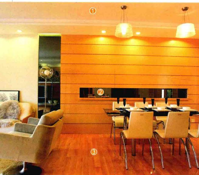
餐厅背景墙面用水泥砂浆找平，墙面防潮处理后用木工板打底并做出层板，墙面贴装饰面板后刷油漆。用粘贴固定的方式将银镜固定在底板上，完工后用硅酮密封胶密封。
