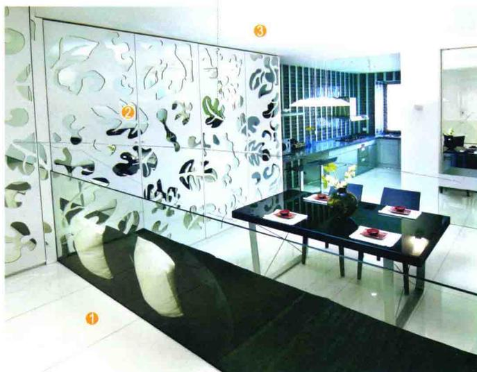
餐厅背景墙面用水泥砂浆找平，部分墙面防潮处理后用木工板打底。剩余墙面满刮三遍腻子，用砂纸打磨光滑，刷底漆、面漆。用粘贴固定的方式将银镜固定在底板上，完工后用密封胶密封。
