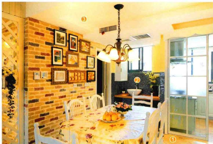
餐厅背景墙面用砖砌成后, 清洁好表面的水泥砂浆, 用白色水泥勾缝。整个墙面刷清漆。
