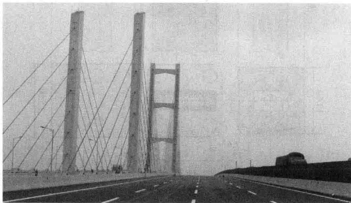
图 1.3 扩建后的九江大桥
