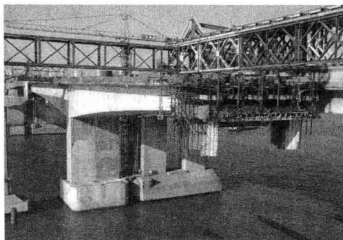
图 1.6 改扩建九江大桥采用的单薄壁墩结构
