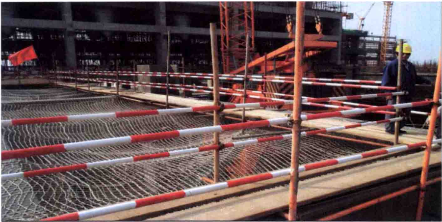
图 1-1 现场安全走廊
