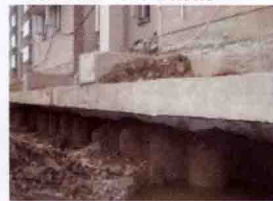
截桩纠倾法用于纠倾采用水泥搅拌桩的七层楼房
