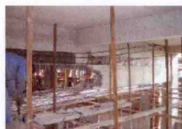
体外预应力技术用于减小梁截面高度
