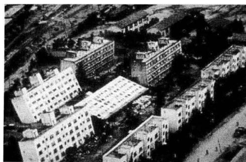
图 1.9 日本新潟砂土液化地基丧失承载力
