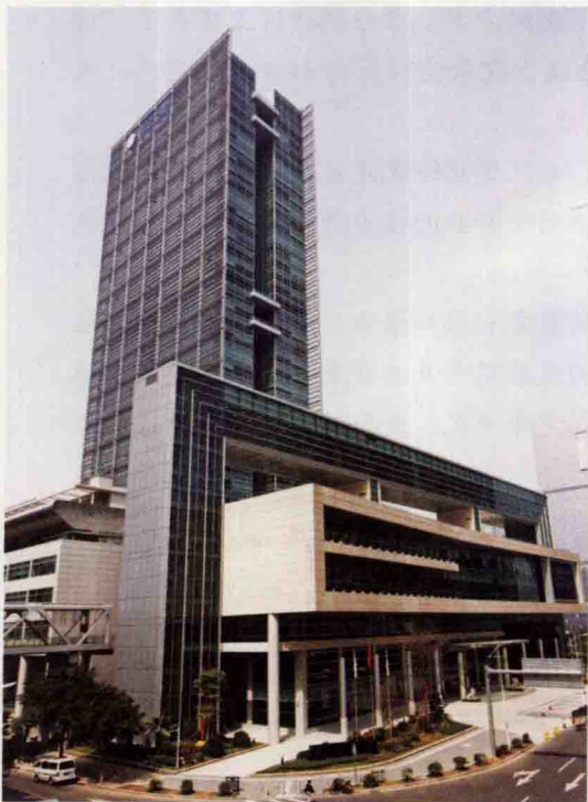
图 2 东裙楼及数码廊外观
