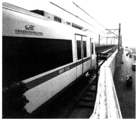
图 1-2-9 天津津滨轻轨铁路
