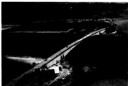
图 1-1 Koror-Babeldaob 桥倒塌前
