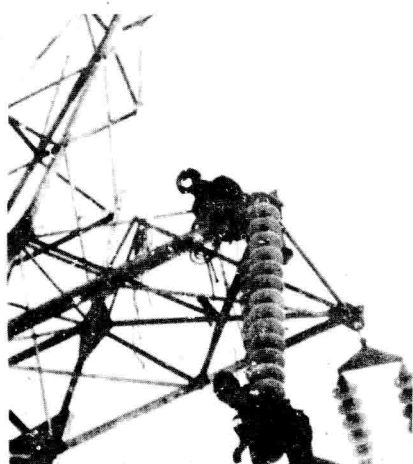
1953 年 11 月，送变电 工程公司组塔工序工人们 在“506”工程建设中安装塔头。
