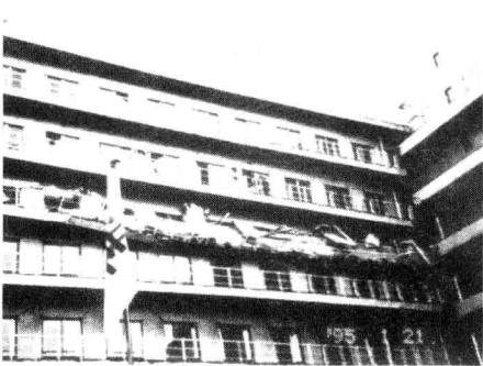
图 1-15 阪神地震某医院中间薄弱层（第五层）倒塌，首层完好
