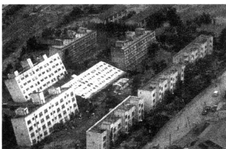
图 1-7 1964 年日本新潟地震，地基液化导致楼房倾斜倒塌
