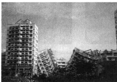
(a) 倒塌现场照片
