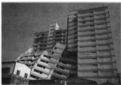
(a) 倒塌照片
