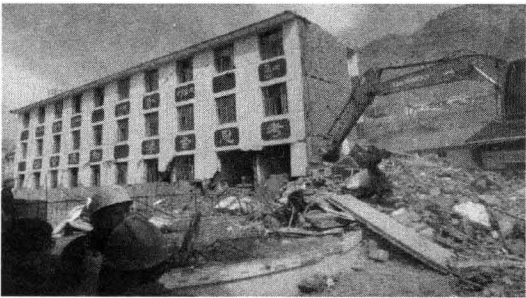
(a) 防震缝两侧的结构单体相互碰撞，东侧结构完全倒塌
