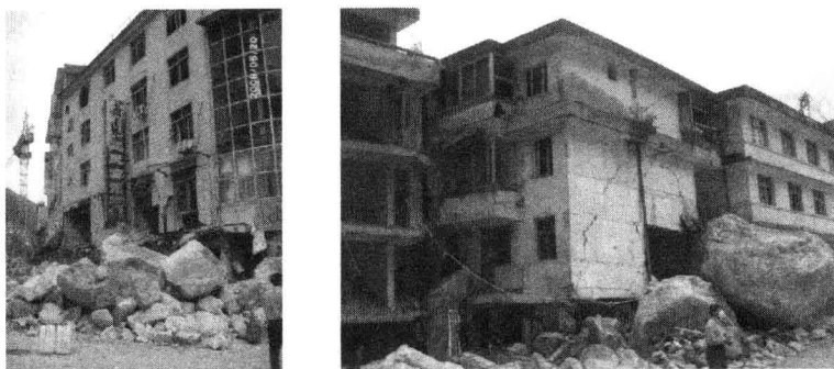
图 1-5 2008 年汶川地震中山体崩塌产生的巨大滚石，造成了建筑的破坏
