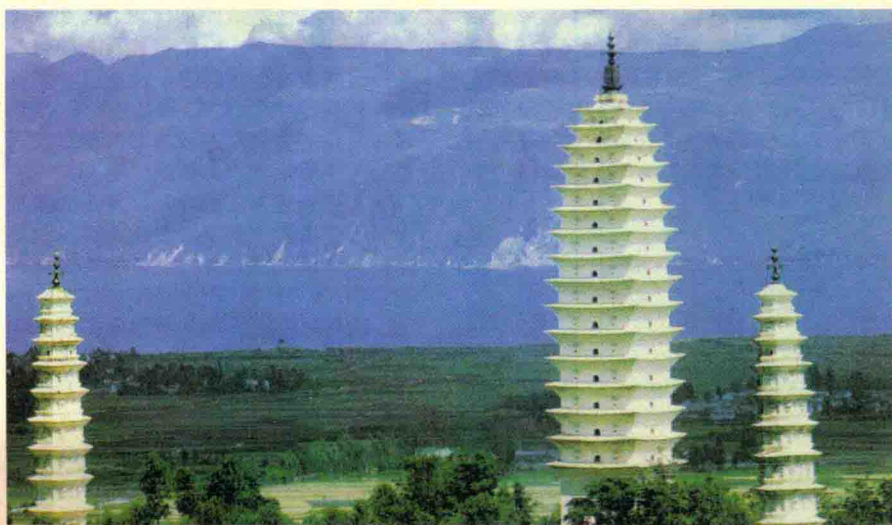
位于云南大理的崇圣寺三塔。主塔千寻塔建于唐中叶，为唐代密檐式方塔的典型代表。两侧的小塔，建造年代略晚于千寻塔，是五代时的建筑。
