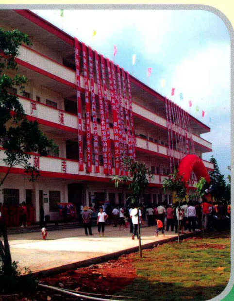
2009年8月28日,宾阳县东黎小学举行落成典礼,这是广西第一栋竣工的校舍安全工程项目
