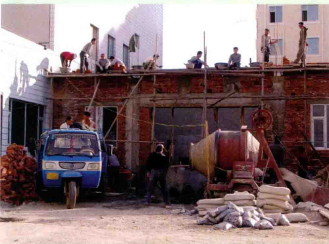
兴建四平市神农医院急诊大厅
