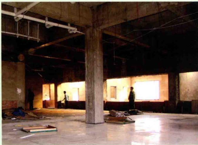
兴建四平市神农医院门诊大厅
