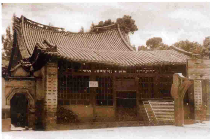
城隍庙大殿（已拆除）
