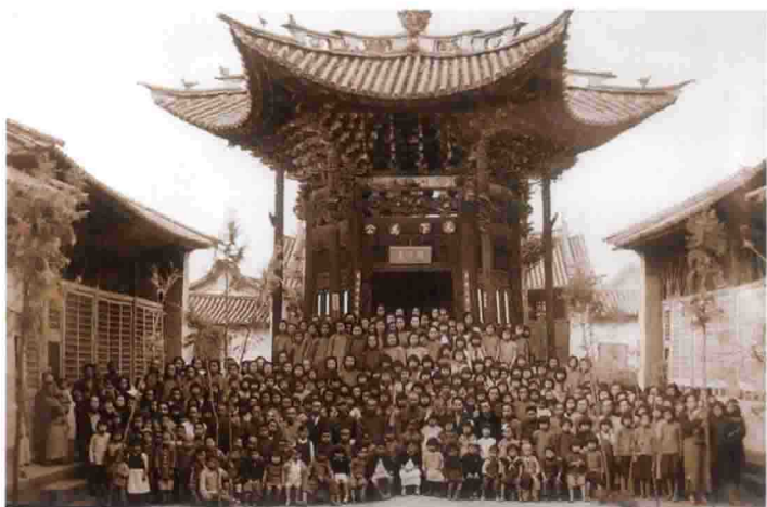
万寿亭（已拆除）
