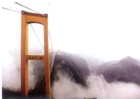
(b) 沪蓉西高速四渡河大桥
