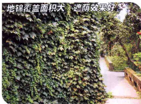
图1-30 地锦墙面绿化
