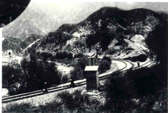
为保证下坡方向的行车安全，在青龙桥与南口间的各会让站建有避难线，以防列车溜逸失控造成事故 (1909年)。
