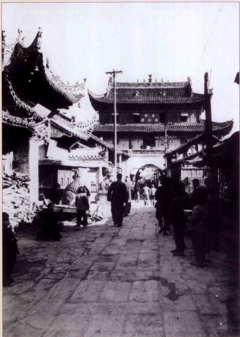
○明代建筑钟鼓楼
