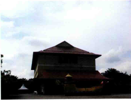
马来西亚佛光山东禅寺修持中心
