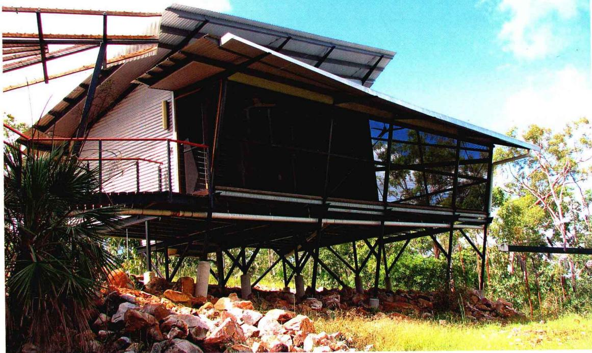
图为位于澳大利亚北部地区的班奈特湖的洛扎克房屋，以围护结构创建一个最小的建筑边界，在实现零能源消耗和低碳排放的目标中起到关键作用。太阳能装置附在门廊、百叶窗、镂空墙壁和地板上，同时搭配具有可调节的连接系统。
