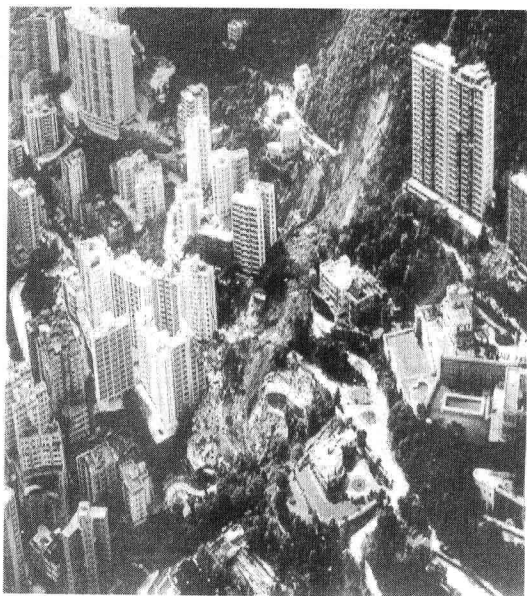
图 0-3 香港宝城大厦被冲毁倒塌
