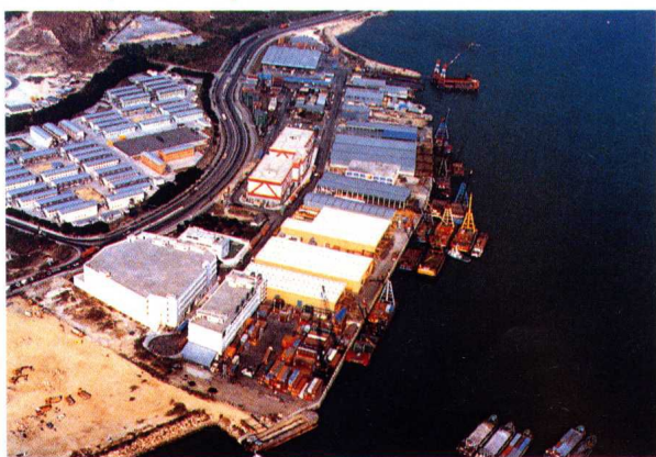
圖 35.6 屯門內河貨運碼頭是裝卸貨物的重要設施。為了應付對貨櫃處理設施日益殷切的需求，政府
