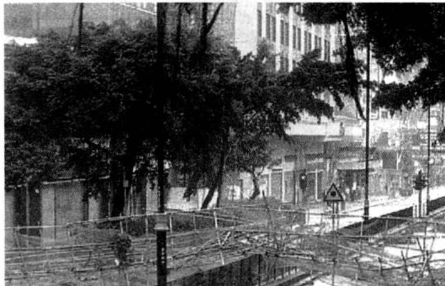
棚架倒塌在道路上。
