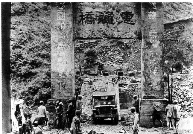
爱国华侨梁金山捐资修建的惠通桥
