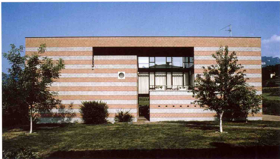
瑞士籍建筑大师马里奥·博塔设计的提契诺州村落民居建筑物的墙壁，使用的彩色石块在视觉上呈现出线条状，从而达到与意大利罗马式教堂相似的设计效果。
