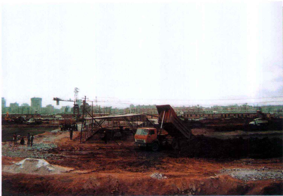
1992年中国昆明出口商品交易会场馆开始动工修建，1993年竣工，1993年8月8日首届昆交会召开。图为工地现场
