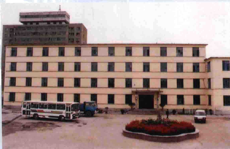
4. 新建二公司办公楼。
