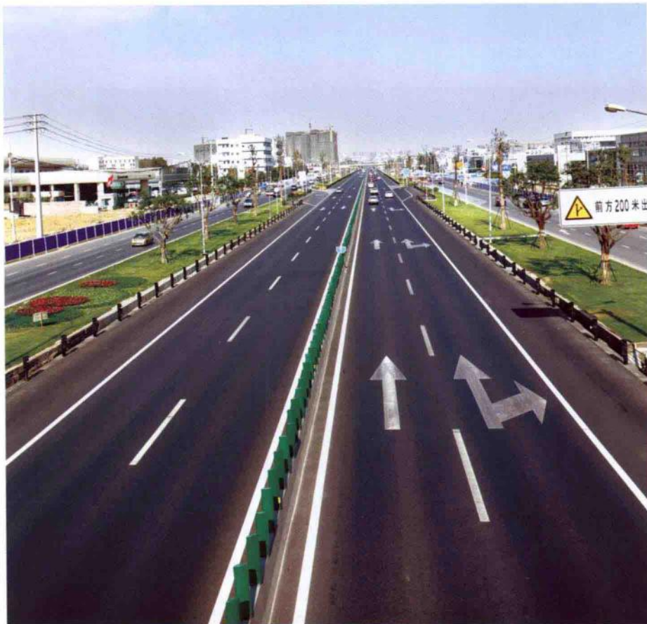
机场高速公路
