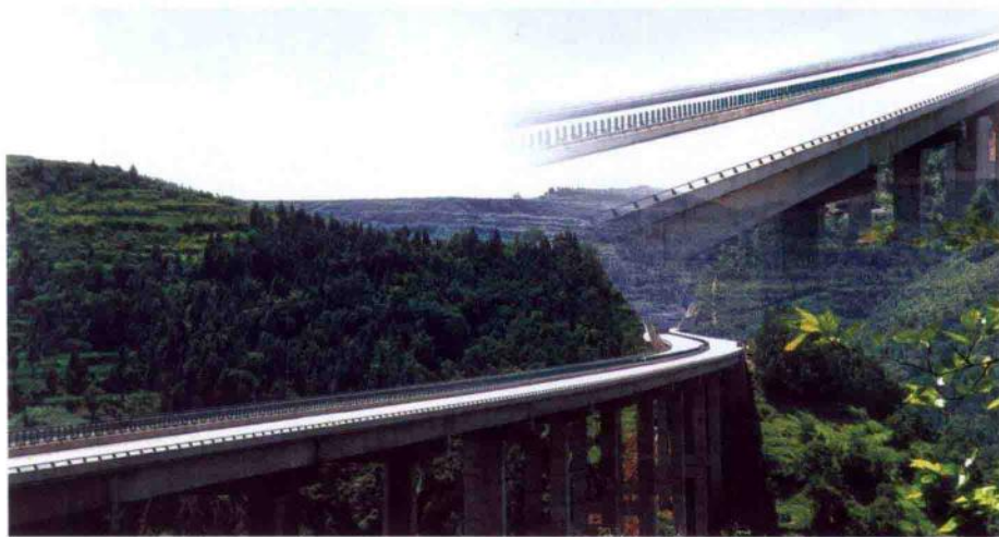
重庆万（州）—梁（平） 高速公路甘宁水库大桥
