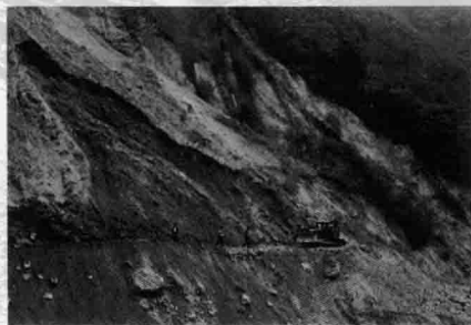
位于川藏公路102道班附近的大坍方(通麦)
