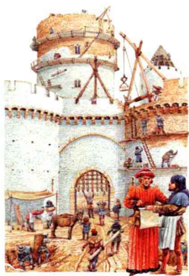
中世纪城堡建设现场
