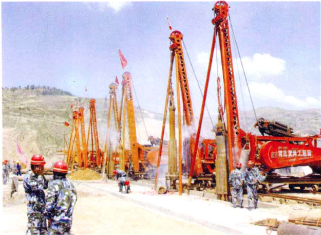
柏叶口公路改移工程
