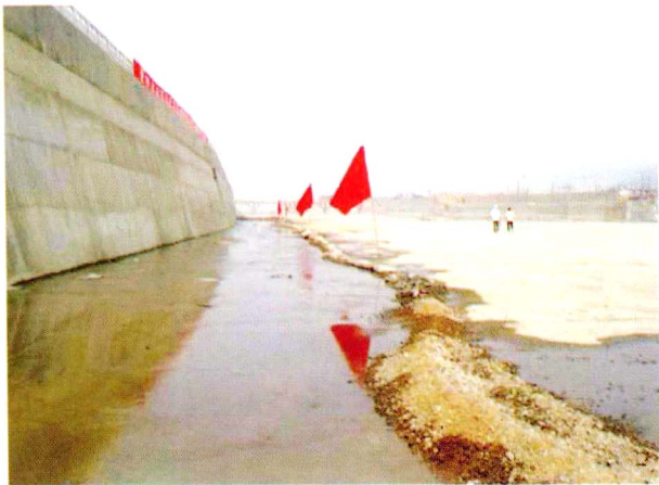
东川河清淤蓄水
