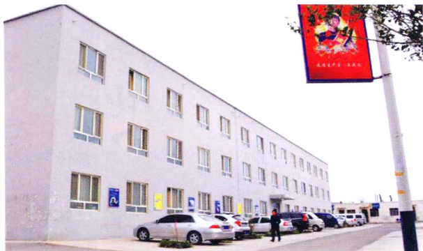
公司兴建廉租房 300 多套，改善了员工居住条件
