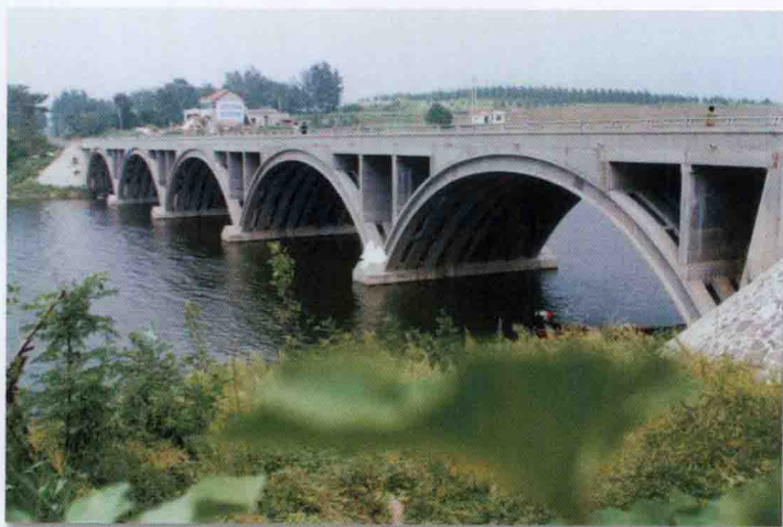
提高旧桥承载能力加固技术
