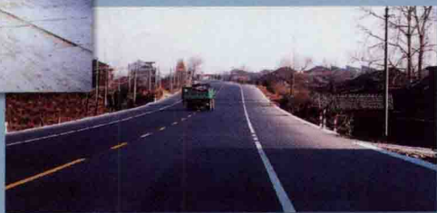
沥青加铺层改造旧水泥路面的研究
