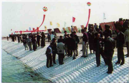
汾灌高速公路土工模袋护坡
