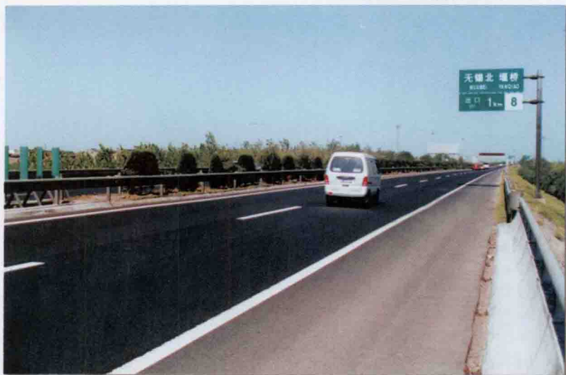
高速公路沥青及沥青混合料路用性能评估
