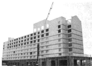
图 1.8 NASFA 某多层冷弯薄壁型钢住宅
