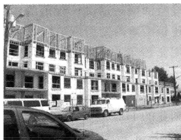
图 1.9 CSSBI 某多层冷弯薄壁型钢住宅
