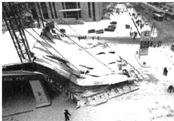
图 1-7 雪荷载过大压垮加油站的屋顶
