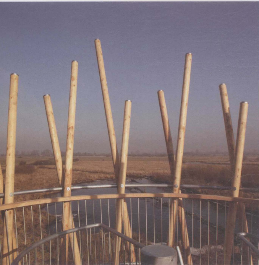
圆形的观景台由波状的木支架构成，坚硬的落叶松树柱以交叉和对角方式连结起来，作为观景台的支撑，形成引人注目的外立面结构。
