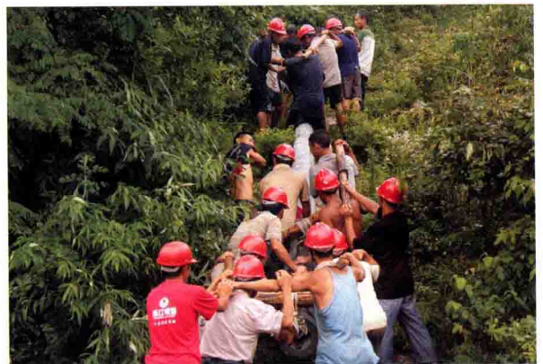
抢修电力设施
