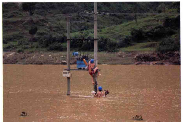
抢修供电设施
