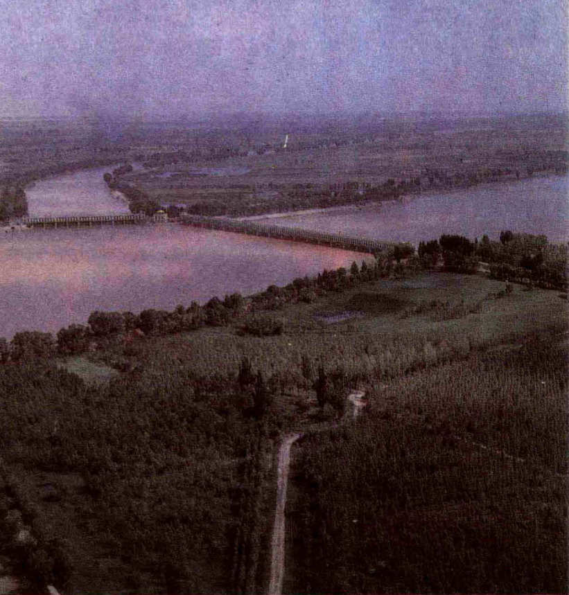
三盛公水利枢纽工程
