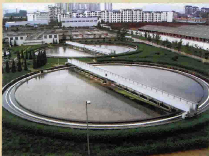
昆明污水处理厂 供稿：昆明市委政研室
