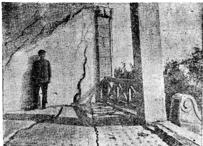
第13圖 馬山得爾地方由於坍塌造成療養院房屋損壞的情形
