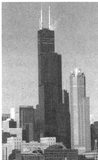
图 1-8 西尔斯塔楼(束筒,1974 年, H=443.179 \text{ m} , n=110 ,用钢量 161 \text{ kg/m}^2 )
