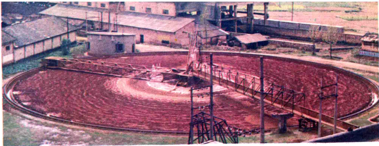
铁坑铁矿选矿直径为50米的浓密池
