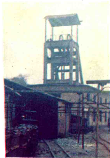
上珠岭铁矿主井提升
