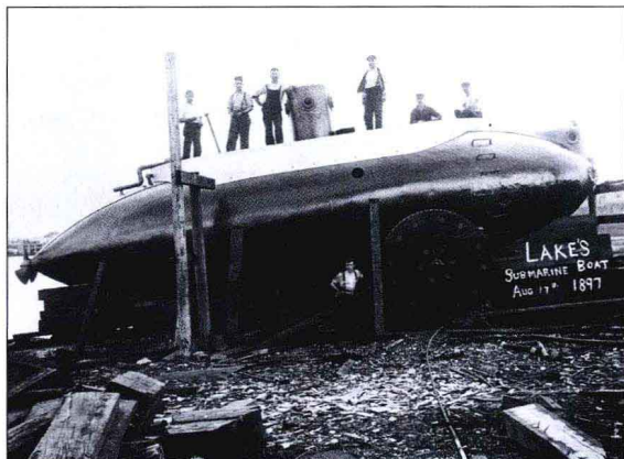
右上图所示：展现的是西蒙·莱克的第一艘潜艇阿戈尔号的内部结构。这艘潜艇建造于1895年，创新特性随处可见，包括可支持潜艇下潜航行24小时。左图所示：阿戈尔号与众不同的车轮，增加了底部爬行功能和潜水员孔空气锁舱门，这些设计在图上都可以清楚地看到。下图所示：随风飘扬的旗帜，相比起霍兰号，阿戈尔号没有被美国海军所接受，因此莱西开始为奥匈帝国海军设计潜艇，但是莱西却在第一次世界大战结束之后相继为美国海军设计了24艘潜艇。
