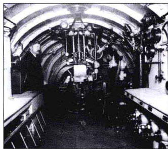
右上图所示：展现的是西蒙·莱克的第一艘潜艇阿戈尔号的内部结构。这艘潜艇建造于1895年，创新特性随处可见，包括可支持潜艇下潜航行24小时。左图所示：阿戈尔号与众不同的车轮，增加了底部爬行功能和潜水员孔空气锁舱门，这些设计在图上都可以清楚地看到。下图所示：随风飘扬的旗帜，相比起霍兰号，阿戈尔号没有被美国海军所接受，因此莱西开始为奥匈帝国海军设计潜艇，但是莱西却在第一次世界大战结束之后相继为美国海军设计了24艘潜艇。
