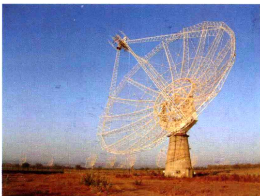
图2 巨米波射电望远镜(GMRT)中自动指向的45m 抛物面碟形天线,位于印度浦那。GMRT 具有30个45m 直径的抛物面碟形天线,其中有14个天线组成中心阵列。图片由来自印度浦那 GMRT 的 Govind Swarup 教授提供。
